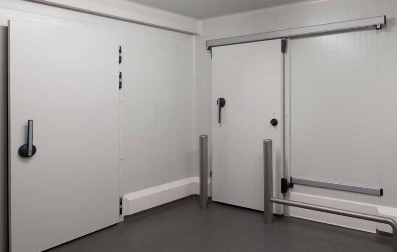
Note : Les portes ci-dessus sont installées sur des panneaux IND avec des cadres fixes.
