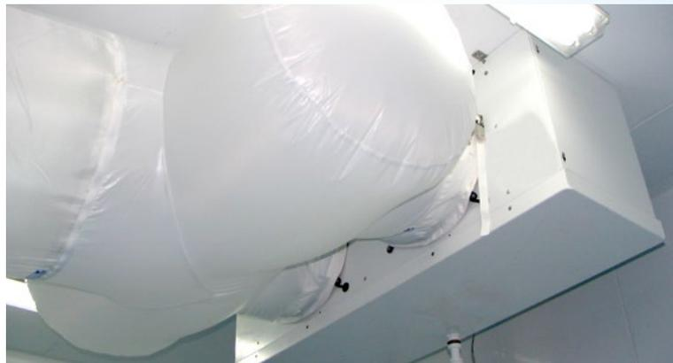
Option VGT permettant la fixation de la gaine textile (non fournie).
