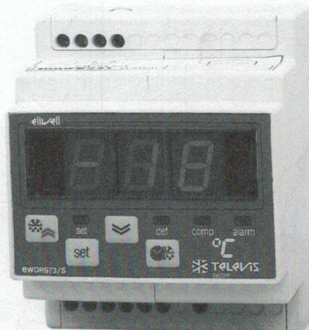
**DEFROST** (dégivrage manuel): une pression continue sur cette touche pendant 7 secondes permet d'obtenir un dégivrage immédiat. Le dégivrage n'est possible que si la température de l'évaporateur est inférieure à la température de fin de dégivrage. Le dégivrage suivant est décalé et automatiquement re-positionné dans le temps en fonction des intervalles prévus.
